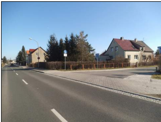
Foto: neugestalteter Straßenraum Beuchaer Straße
