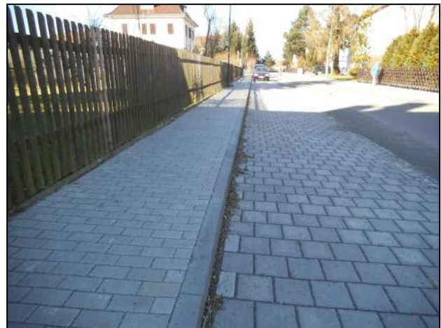
Foto: neugestalteter Straßenraum Poststraße
